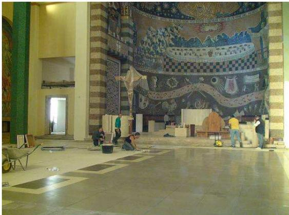
2. Il rifacimento del pavimento ha permesso di rivedere anche il sistema di riscaldamento e climatizzazione della Chiesa, attualmente scarsamente efficiente e notevolmente fastidioso. Si è deciso di adottare un sistema radiante a pavimento, ideale per ambienti alti e voluminosi come le chiese.
